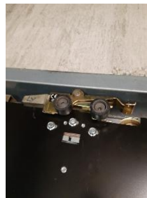
Serrure de porte palière du niveau principal
