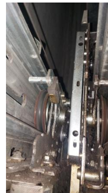
Serrure de porte palière du niveau principal
