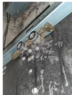
Serrure de porte palière du niveau principal
